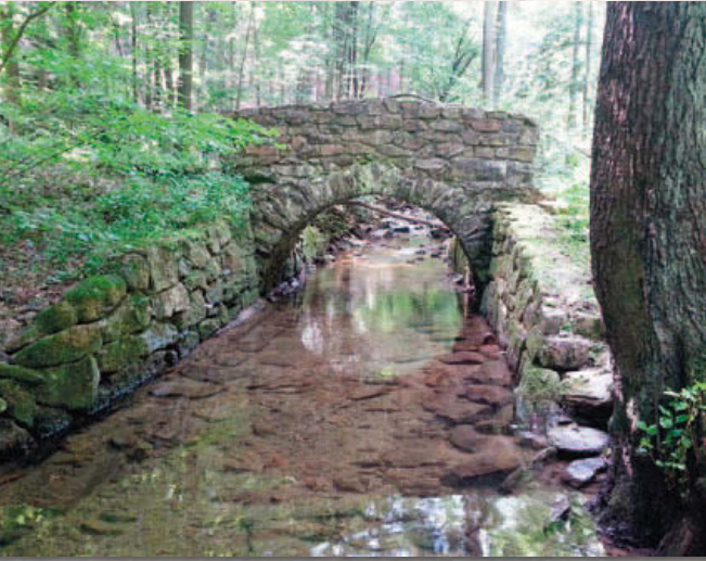
kleine historische Brücke im Trebnitzgrund
