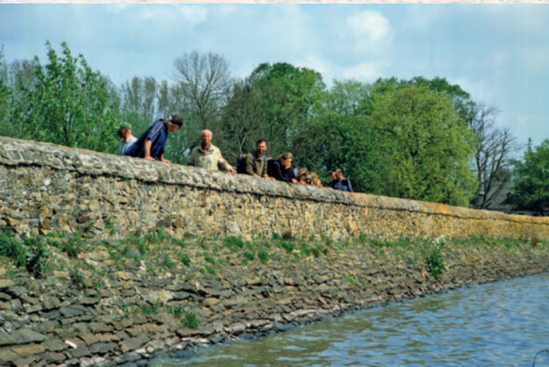
Auch die Naturstein-Staumauer ist ein interessantes Biotop.
