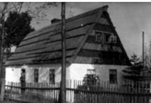
Foto: Došková střecha na chalupě v dnes již zaniklých Habartcích
